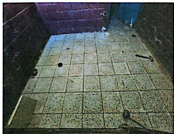
Foto 3: MEJORAMIENTO Y SUSTITUCION DE PISO
