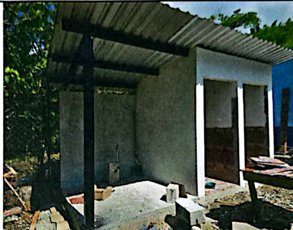
Foto 2: MEJORAMIENTO DE SERVICIOS SANITARIOS Y SUS ACCESORIOS
