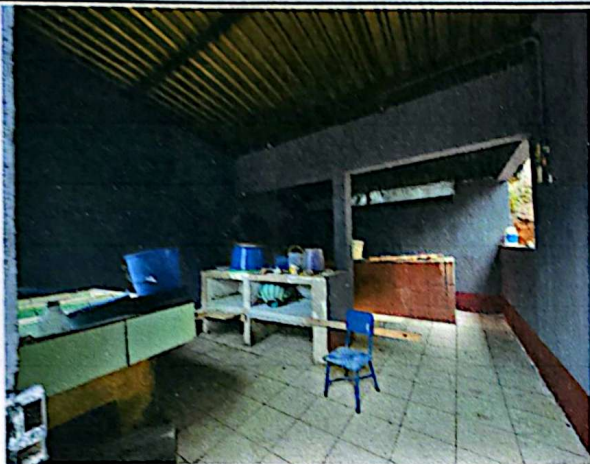
Foto1: REPARACIÓN O SUSTITUCIÓN DE ÁREAS DE COCINA
